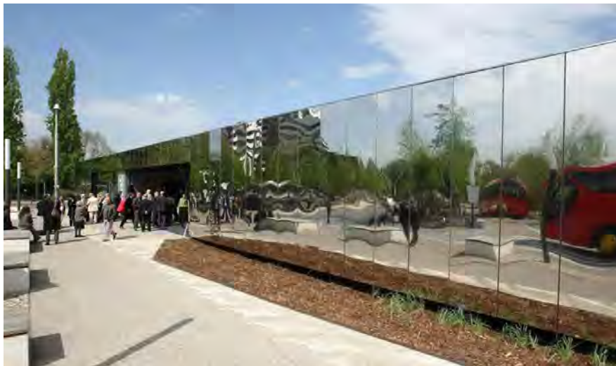
Les travaux du pavillon touristique ont débuté en mai 2011, avec une interruption d'un mois et demi à Noël. PHOTO DNA - LAURENT REA
